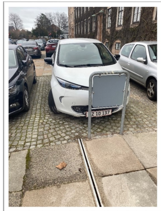
Installation af ladeudtag på væggen og kabelskinne mellem fliserne.
